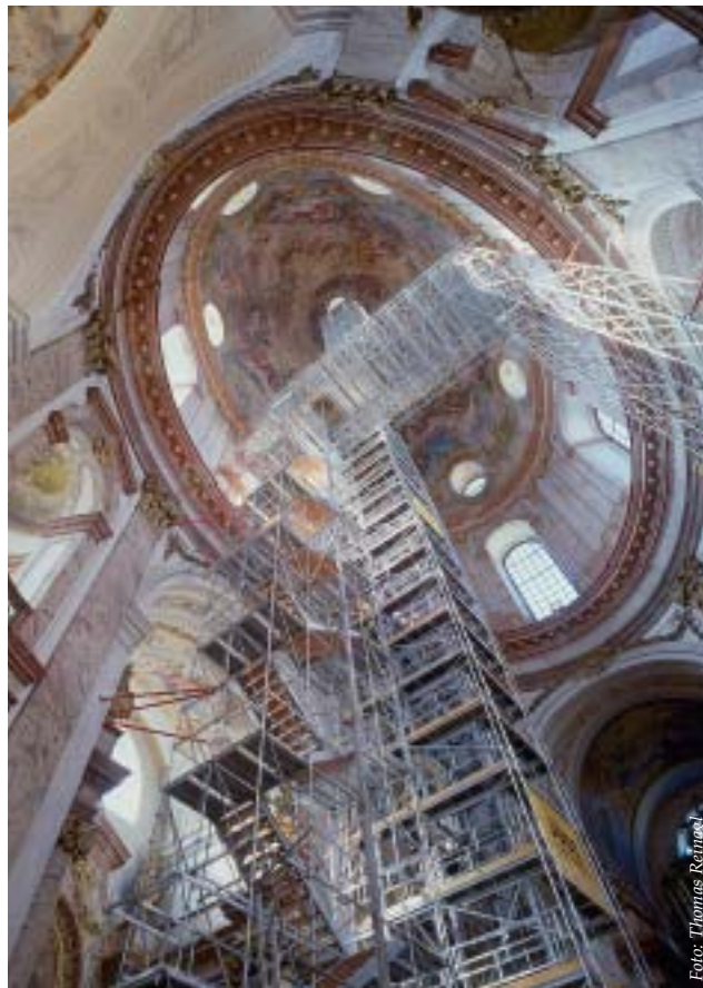
Liftnanlage und Gerüst im Kirchenraum
